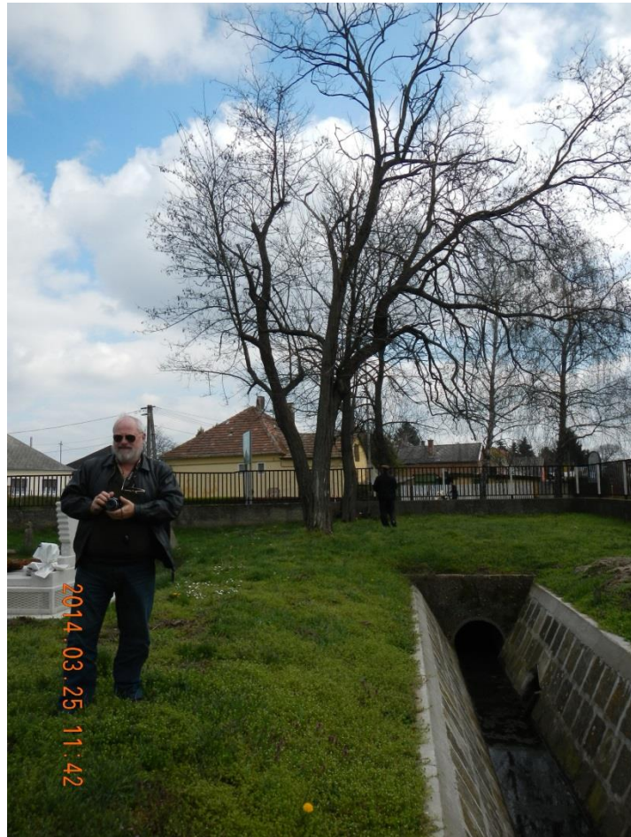
55. kép Régi temető csapadékvíz árok
